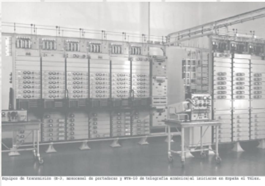
Equipos de transmisión (E-3), monocanal de portadoras y WTR-18 de telegrafía armónica al iniciarse en España el télex.
