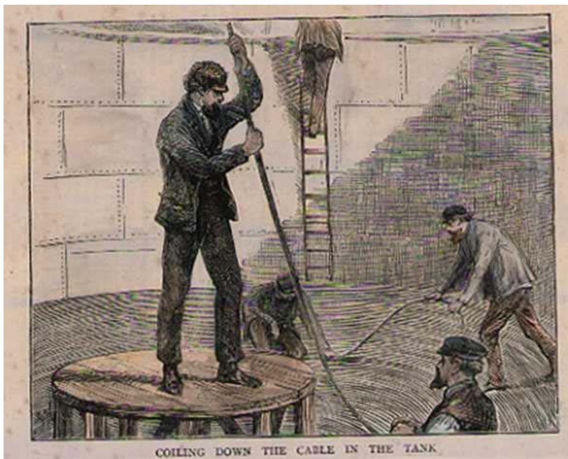
Fabricación del cable telegráfico: Bobinado del cable en el tanque 'The Graphic' 22 de Marzo de 1.873.
