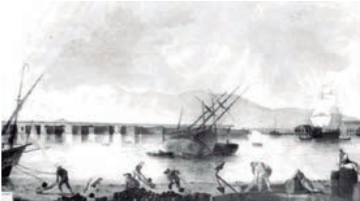
Trabajos en el arsenal de Cartagena, siglo XVIII. (Imagen: Región de Murcia digital)
