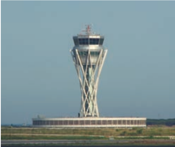
Torre de control del Aeropuerto de El Prat (Barcelona)
