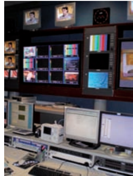
Vista de una de las salas técnicas de control de Aragón Televisión.
