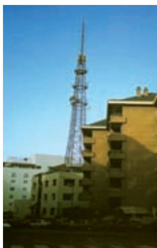
Estudios y torre del Paseo de la Habana, centro emblemático con los que se inició Televisión Española en octubre de 1956. Estaban situados en el barrio de Chamartín de Madrid. Fueron durante bastantes años el centro de referencia pero, finalmente, su emplazamiento se vio afectado por el arrollador urbanismo y sus principales funciones fueron superadas por centros más modernos y eficaces. Este centro dejó de prestar servicio en la década de los 90.
