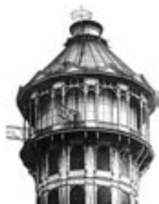
Fig. 15.- Una de las torres del Crystal Palace, donde se instalaron los transmisores de televisión de VHF de Baird. En el balcón inferior se aprecia la antena por la que se emitía el sonido y las señales de sincronismo, mientras que en la parte más alta se puede observar la antena del transmisor de vídeo.
