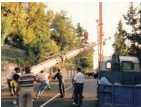
Tubo soporte del supertunstile en el momento de tomar tierra. Al fondo el brazo de la grúa.
