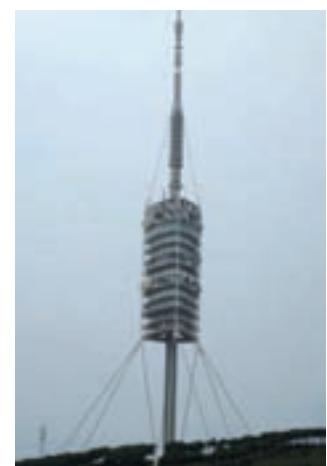
Estación Collserola (Barcelona), inaugurada en 1992 con el fin de mejorar las infraestructuras de la red de televisión para los Juegos Olímpicos.
