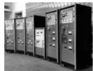
Equipos reemisores de diferentes potencias. Estos equipos captan una señal procedente de un Centro Emisor de Televisión y la «reemiten» hacia una zona en la que no se captan las señales.
