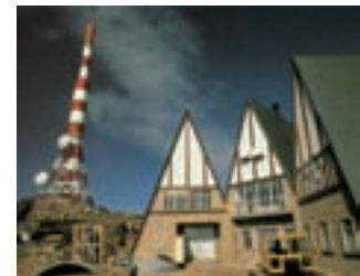
Centro emisor de Javalambre.- Está situado en la Puebla de Valverde (Teruel), en la sierra de Javalambre, a 2.020 metros sobre el nivel del mar y se puso en servicio en 1974. Si bien su cobertura es extensa, la población directamente cubierta por este centro es muy reducida, sólo unos 45.000 habitantes, y en él no se han instalado equipos de la televisión privada.
