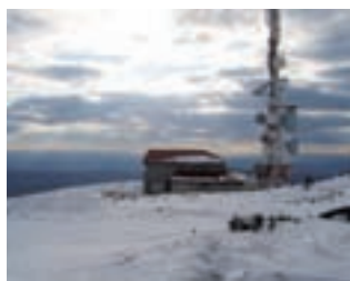
Centro emisor de Meda. Este Centro se puso en servicio en 1975, está emplazado en el término municipal de Montederramo (Orense) y su altura sobre el nivel del mar es de 1.323 metros.
