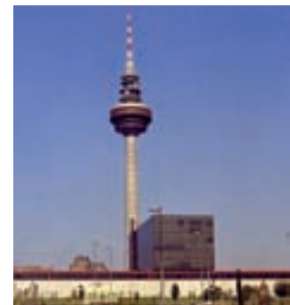
Instalaciones de Torrespaña. En la fotografía se puede ver el edificio de siete plantas en el que se habilitan cuatro platós de tamaño medio, que permiten producir informativos y pequeños programas. Fuente: TVE.
