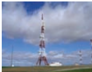
Centro emisor de Matadeón. Está situado en el término municipal Matadeón de los Oteros (León), a una altura de 910 m sobre el nivel del mar y su torre tiene 128 metros de altura. El origen de este centro data de 1961, cuando se instaló allí la estación del radioenlace de la ruta del norte.
