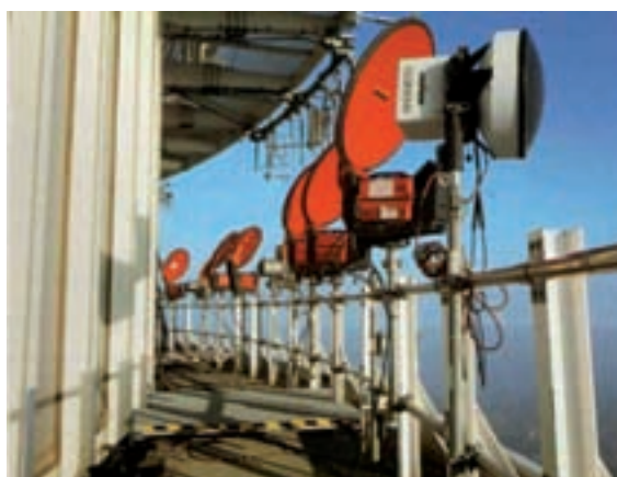
Corona exterior de la planta sexta. En principio se pensó cerrarla con paneles de fibra de vidrio para facilitar la instalación de enlaces móviles de televisión en su interior. Comprobada la atenuación radioeléctrica que estos paneles introducían se optó por dotar a su contorno de una estructura metálica adecuada para la instalación rápida de múltiples enlaces móviles.
