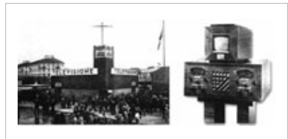
Fig. 34.- Izda.: Pabellón de la empresa SAFAR en la Feria de Milán de 1934. Puede apreciarse la antena transmisora de televisión de VHF colocada en la parte alta del edificio. Dcha.: Receptor de televisión de VHF a 180 líneas y 25 cuadros/segundo fabricado por SAFAR, utilizado durante la demostración.
