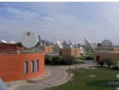
La estación internacional de satélites de Arganda fue construida por Retevisión como complemento imprescindible de la red terrestre. Desde su puesta en servicio constituyó el referente máximo del tráfico de señales de TV vía satélite en España. En la actualidad es propiedad de Abertis y sigue cumpliendo el mismo cometido.
