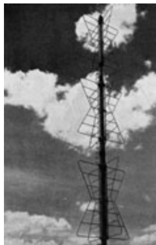
Figura 23. Antena de televisión superturmstile de tres elementos de 90 metros de altura, instalada en la torre del edificio del Paseo de La Habana 77. (Revista de Telecomunicación. Diciembre 1955. pp. 88).
