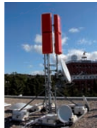
Figuras 9 y 10 – Sistema de antenas para Campus HD, el piloto pionero en España de emisiones reales en Televisión de Alta Definición con servicios interactivos, ubicado en la Escuela Técnica Superior de Ingenieros de Telecomunicación de la Universidad Politécnica de Madrid.
