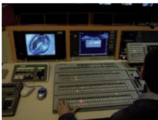
Estudio de control de Televisión Española. Desde aquí se comprueba que las señales salgan al aire de manera adecuada. Fuente: TVE
