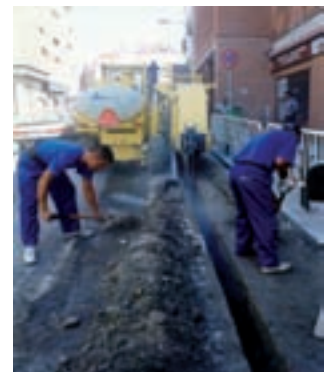
Fotografía del tendido de cable, en el que se utiliza una máquina zanjadora para construir las canalizaciones.
