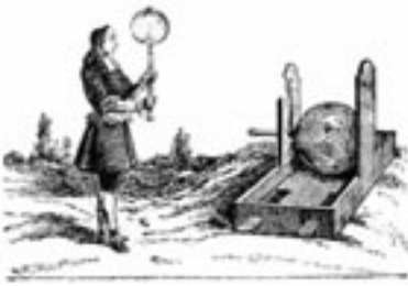
El primer generador eléctrico construido por Guericke, usando una bola rotatoria de azufre.
