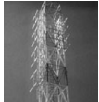
Antena de dipolos. Este tipo de antenas constituyen el elemento básico en la mayoría de las antenas transmisoras de televisión.
