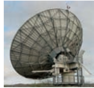
Estación terrena. Es un enlace entre los estudios y el satélite, que a su vez, difunde la señal directamente sobre amplias zonas geográficas.
