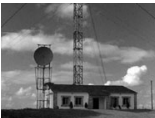
Infraestructura típica de un centro de televisión en el que se puede ver el radioenlace.
