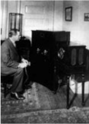
Figura 21. En la fotografía aparece Alexanderson, sentado delante del televisor y del receptor de radio en su casa de Schenectady. En la mano sostiene un pequeño mando que le servía para ajustar, manualmente, el sincronismo del televisor. La pantalla se encuentra en el centro de la parte superior del mueble. Fuente: Archivos de la General Electric.
