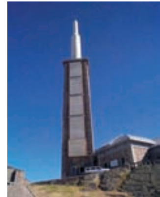
Centro emisor de Peña de Francia. En la Peña de Francia (Salamanca) a 1705 m de altitud fue construido este centro en 1978. Las características del lugar, con un monasterio Dominicó del siglo XV en las proximidades, aconsejaron la utilización del granito en la edificación singular que nos muestra la fotografía.
