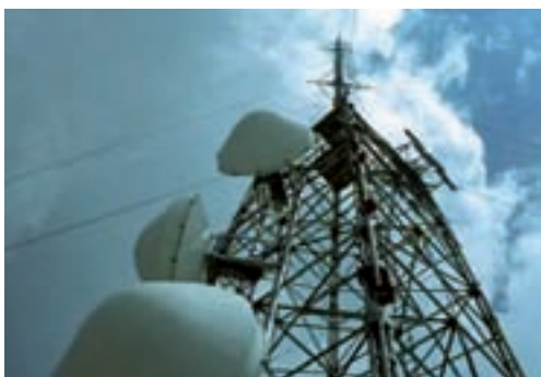
Antena de televisión de Aitana en Alicante. En este centro se instaló una emisora de 10 kW. de potencia que, emitiendo en el canal 3, prestaba un eficaz servicio a grandes áreas de Castellón, Valencia, Alicante, Albacete, Murcia, Almería e islas de Ibiza y Formentera. Este centro comenzó a emitir en 1962.
