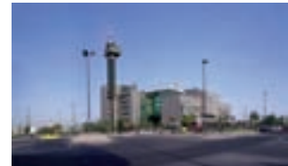
Imagen del edificio de la sede de Telemadrid. El 2 de mayo de 1989, Telemadrid empezaba sus emisiones. Las instalaciones de producción y emisión se situaron, provisionalmente, en los tres edificios de la Agencia EFE. Habría que esperar ocho años para que Telemadrid contara con su propia sede en la Ciudad de la Imagen.
