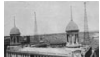
Unión Radio Madrid. Elegante disposición de la antena de Unión Radio Madrid, en la técnica de antena de hilos horizontales tendidos entre dos torres soporte. (1924).
