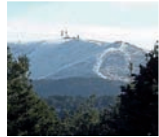
Estación de televisión en La Bola del Mundo, Navacerrada (Madrid), en una cota de 1.248 metros, y una potencia radiada de 600 kW.
