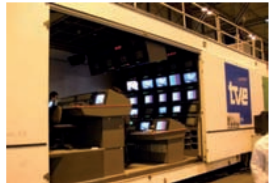
Interior de una unidad móvil tipo C de las que se utilizaron en las Olimpiadas Barcelona en 1992. A la derecha se aprecia el portón que se puede abrir; en el caso de que se quiera colocar otra unidad C de tipo complementario. Esta foto está tomada en el pabellón de IFEMA. Foto: Carlos Alberto Martín.
