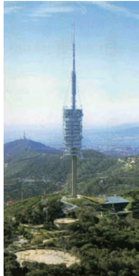
Vista panorámica de la torre de Collserola. En la base de la torre se observan la estructura de religa y el techo ajardinado que cubren el edificio auxiliar. Al fondo se ve la torre de San Pedro Mártir, de Telefónica.
