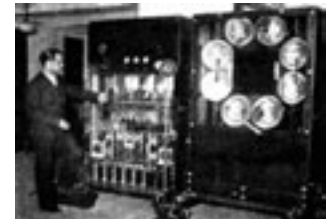
Sistema de proyección de Ulises Sanabria, 1932. Con este sistema este nieto de españoles lograba proyectar imágenes en grandes pantallas situadas en salas públicas.
