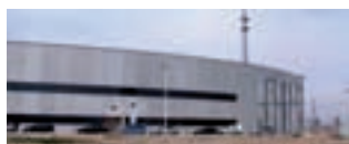
Vista del edificio del Centro de Producción de Programas de 7 Región de Murcia. Inició sus emisiones regulares el 14 de abril de 2006 y su modelo de gestión esta basado en un presupuesto ajustado y una programación externalizada.
