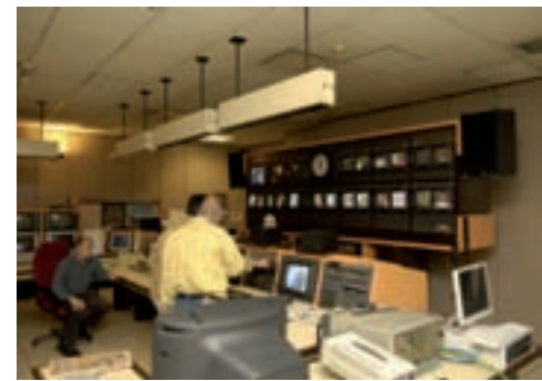
Control central de informativos de TVE. Tanto el control de informativos como el de programas, disponen de ordenadores conectados a la red, al objeto de administrar el control de tiempos del minutado, rótulos, etc. Fuente:TVE.
