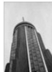
Antena de la estación emisora de televisión de la RCA.
