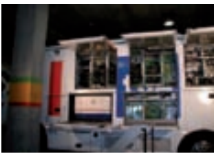
Unidad móvil pequeña que en el portón inferior izquierdo muestra el grupo electrógeno de 10 kW marino insonorizado. El resto de portones sirve para facilitar la operación en la trasera de los equipos y soporta una persona subida en ellos. Fuente: TVE.
