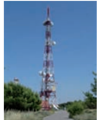
Centro emisor de La Muela.- Situado en el municipio de La Muela, en la cota 560, junto a la nacional II y a unos 15 kilómetros de Zaragoza. La infraestructura de este centro se empezó a construir en 1963 para albergar la estación del radioenlace y el transmisor de TV que en 1958 debieron montarse, por razones de urgencia, en un centro del Ejército del Aire próximo al actual. Fotografía realizada el 7 de julio de 2004.
