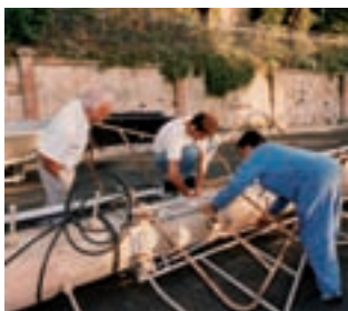
Tubo soporte de la antena supertunstile ya en tierra. Se inicia el proceso de desguace en presencia del director de la zona, Manuel Moralejo Herrero.
