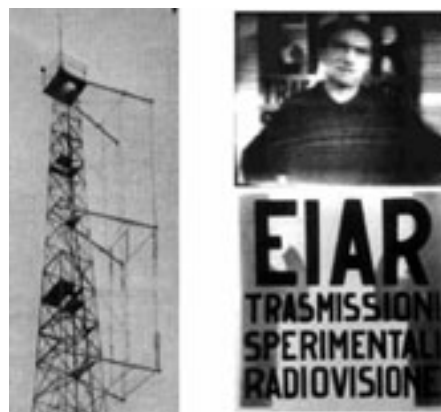
Fig. 35.- Izda.: Antenas transmisoras de televisión de VHF, para vídeo y audio, instaladas sobre una torre de 50 metros en Monte Mario, Roma (1939). Se utilizaban las longitudes de onda de 6,8 metros (vídeo) y 7,4 metros (sonido). Dcha.: Imagen recibida de 441 líneas correspondiente a un locutor durante las emisiones en pruebas del año 1939. En la parte de abajo se reproduce el cartel situado detrás del locutor, que se usaba también como carta de ajuste.
