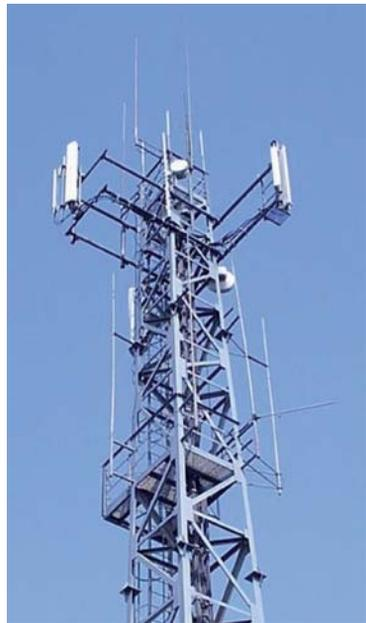
➔ Fig. 8. Antena (BTS) para GSM
