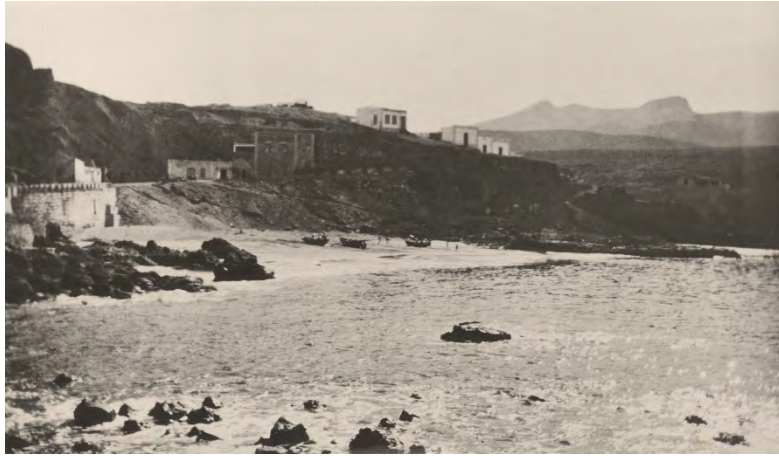
Figura 6.10. Tendido del cable interinsular, Sardinia (Gáldar) 1930.
